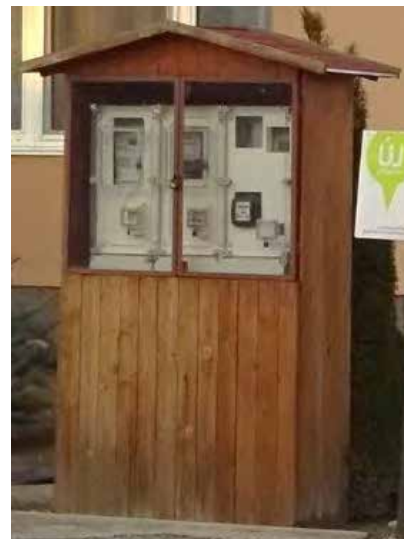
Az előkertben megjelenő energia fogyasztást mérő berendezések elhelyezésének/takarásának jó példája ez a szekrénybe zárt villanyóra.
